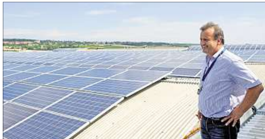
Newi-Solar-Geschäftsführer Siegfried Neff steht auf dem Dach der Ket-Halle in einem Meer aus Solarzellen. Foto: Thomas Müller
